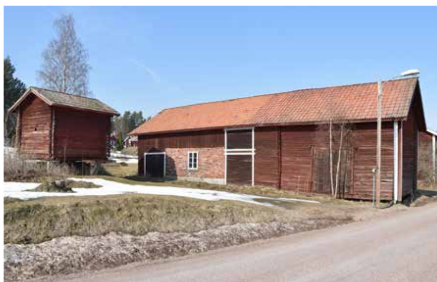
Länga med ekonomibyggnader, typisk för det sena 1800-talet och placerad vid den genomlöpande bygatan. På bilden syns även ett karaktäristiskt härbre. Alvik 102:2.
