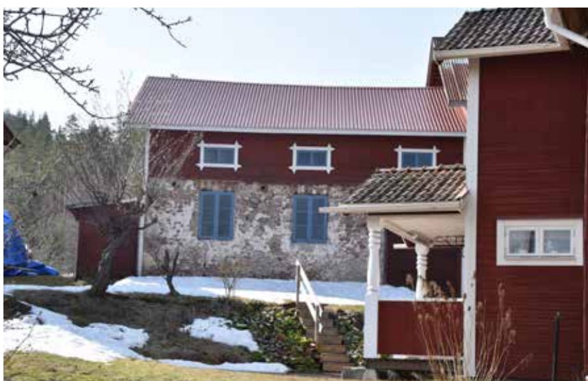
Ladugårdslänga med gutmursdel. I Leksand fanns många som var specialister på att bygga med denna teknik. Alvik 113:1.
