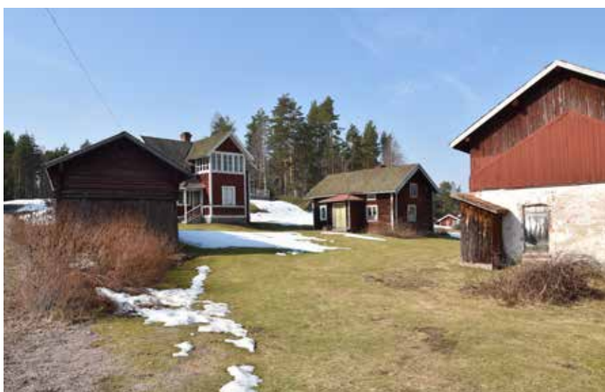
Äldre gård med välbevarad äldre sidokammarstuga och korsplanshus. Kring gårdstunet finns även äldre timmerhus och en ladugårdslänga från det sena 1800-talet. Alvik 97:1.
