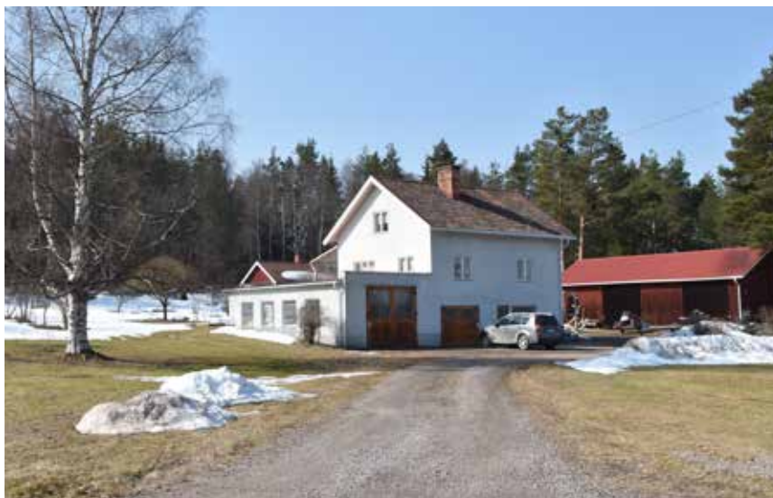
Verkstad i byns nordvästra del. Byggnaden är typiskt funktionalistisk med välbevarade dörrar i oljat ädelträ. Alvik 107:1.
