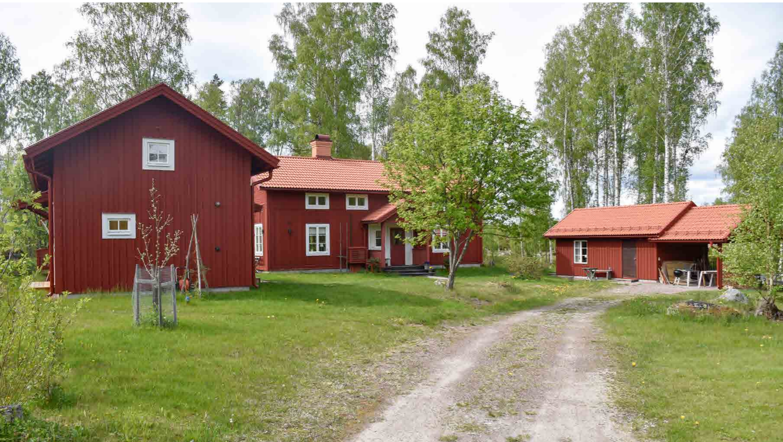
Gård som i sin helhet tillkommit under 2000-talet. Husen är synnerligen väl anpassade till Övre Dalarnas byggnadskultur. Gården är dessutom ordnad så att den skapar trivsamt kringbyggdhet. Östanbol, Leksand.
