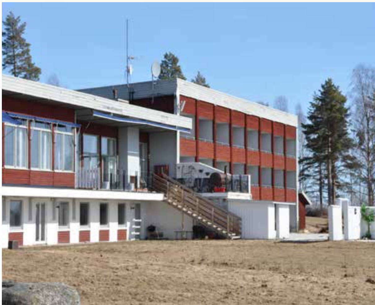
Siljansnäs hotell är en av de modernistiska byggnader som bedömts besitta särskilt kulturvärde. Björken 340:1.
