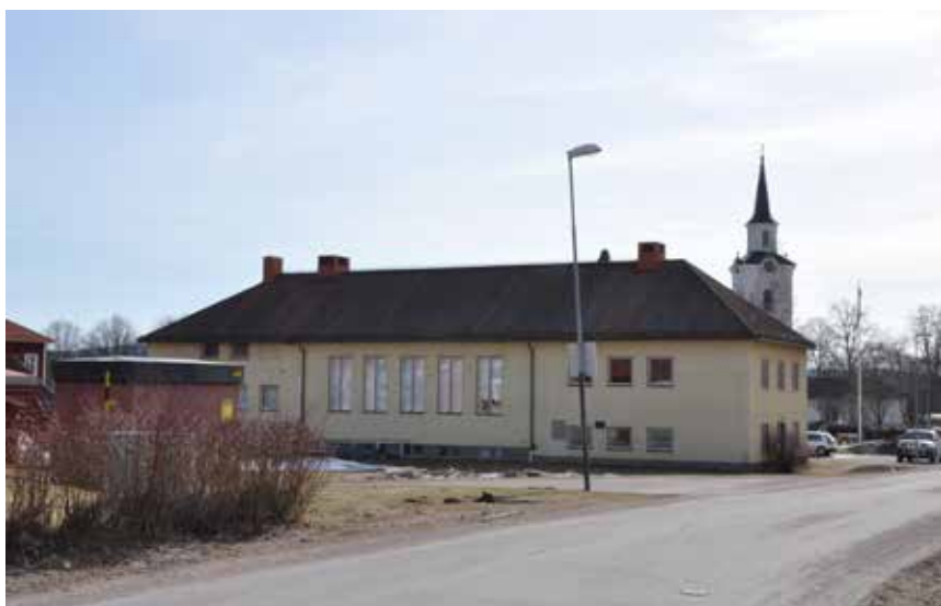
Sockenstugan är en viktig byggnad i Siljansnäs socken-centrum. Särskilt värdefulla är byggnadens fönster, takmaterial, slätputsad fasad och skylten Sockenstugan. Björken 200:39.
