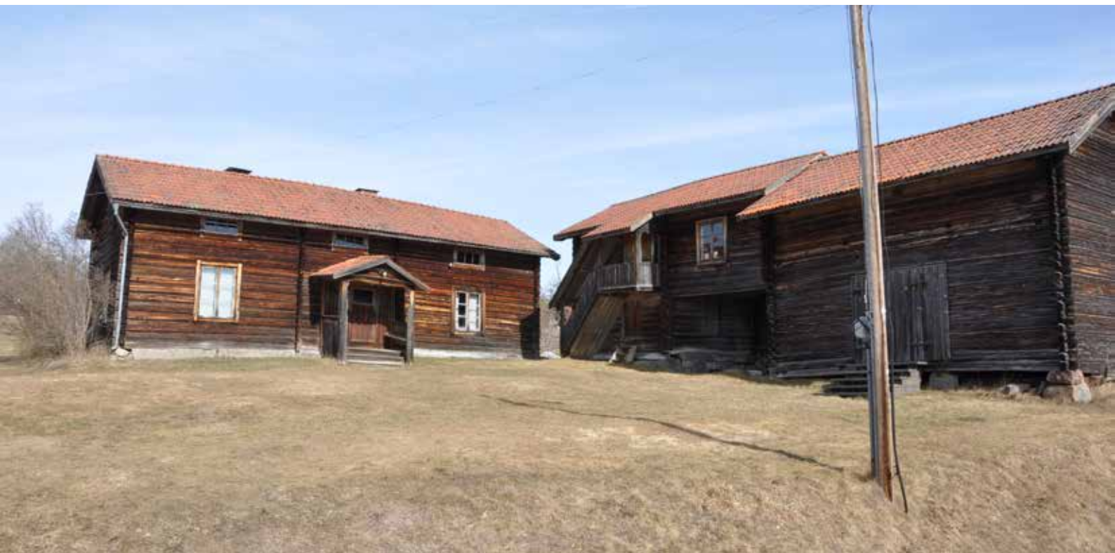
En gård som utglesats på två sidor längs den genomlöpande byvägen. Kvarvarande byggnader, en parstuga, en källarstuga och en trösklada är emellertid mycket välbevarade och värdefulla byggnader. Björken 150:3.
