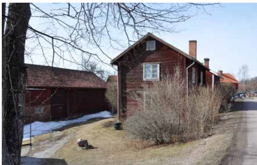
I Västra Björken finns fortfarande enstaka kringbyggda gårdar och en del välbevarade äldre manbyggander. Björken 169:1.
