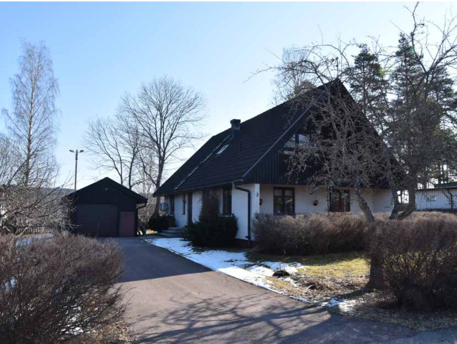
För det sena 1970-talet tidstypiskt småhus med brant sadeltak, »joddlarbalkong«, kalksandstensfasad och belysningsarmaturer med antikglas. Även villaträdgården är tidstypisk för 1970-talet. Edshult 1:86.
