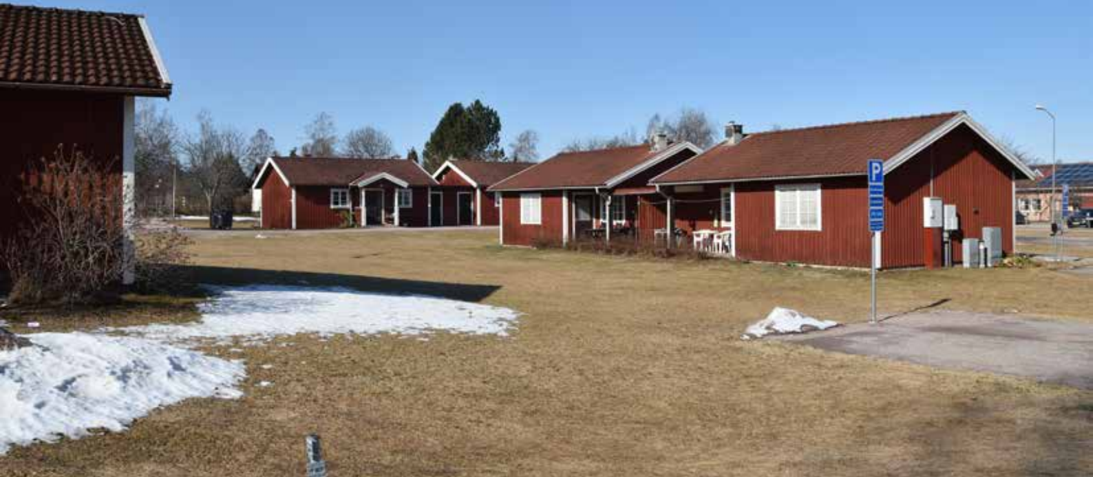
Parhusbebyggelse som är mycket väl anpassad belägen mellan Flottistens väg och Nordstjärnans väg. Byggnaderna är sannolikt uppförda kring 1970-talets mitt. Edshult 1:89.
