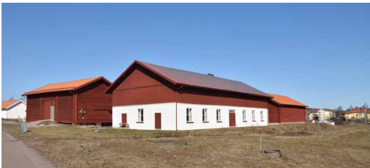
Kvarvarande bebyggelse tillhörande fägården på Övermo gård. Den delvis putsade byggnaden är ett fähus uppfört kring 1850 med bottenvåning i så kallad gjutmur. Gjutmuren tillverkades genom att stapla sten i en form och sedan ingjuta den i kalk. Sannolikt för att hålla gjutförmarna från varandra användes gamla lieblad, som är kvar ingjutna i muren. Leksandskarlarna var under 1800-talet experter på denna nya byggnadsteknik och uppförde ett stort antal sådana stora fähus från Jämtland i norr till Mälardalen i söder. I Övre Dalarna är de däremot mycket ovanliga i denna storlek. Edshult 1:124.
