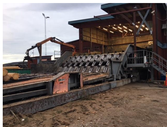
Figur 15. Mätstation, källa position 1
