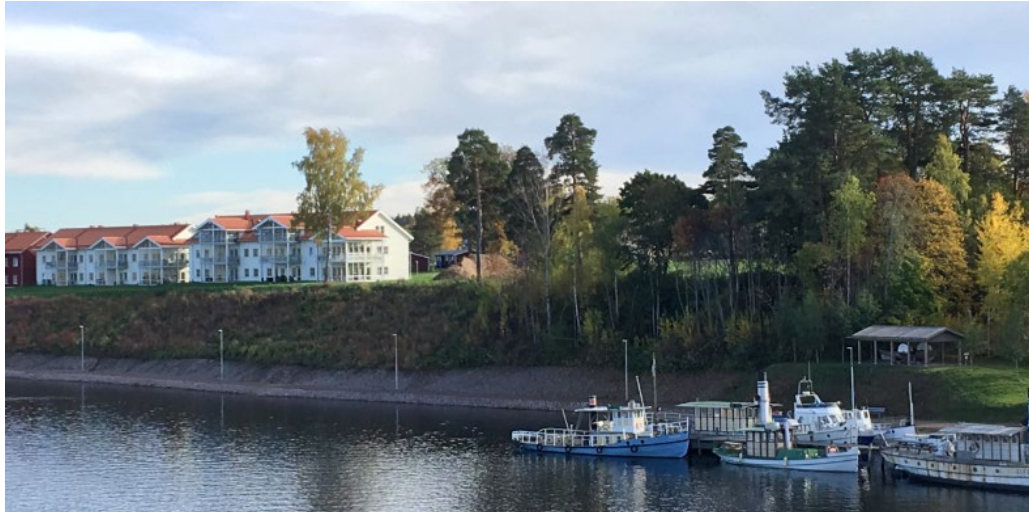
Slänt och vegetation sett från Leksandsbron
