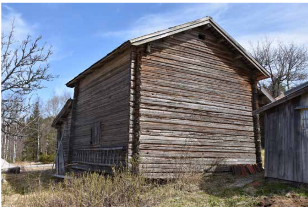
Ett stort antal av fåbodarnas byggnader har förblivit ofärgade med väggar i naturligt grånat timmer. Ovan ses fastigheten Tällberg 1:28 med kringbyggt gårdstun.
