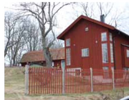
Inspirationsbild, hus i Rinkeby Hölö, Sörmland 2006 arkitekt Sören Thurell
