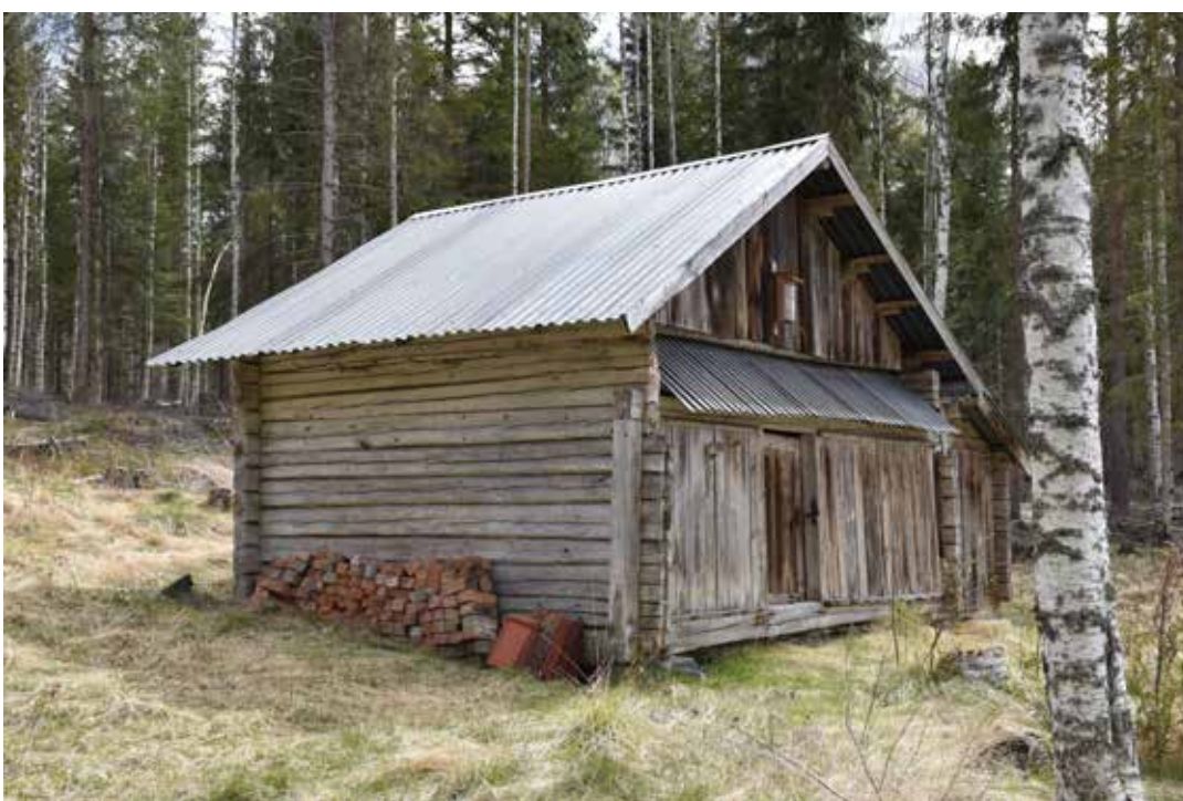
Ålderdomlig bod med senare plåttak. Västra Rönäs 15:5.
