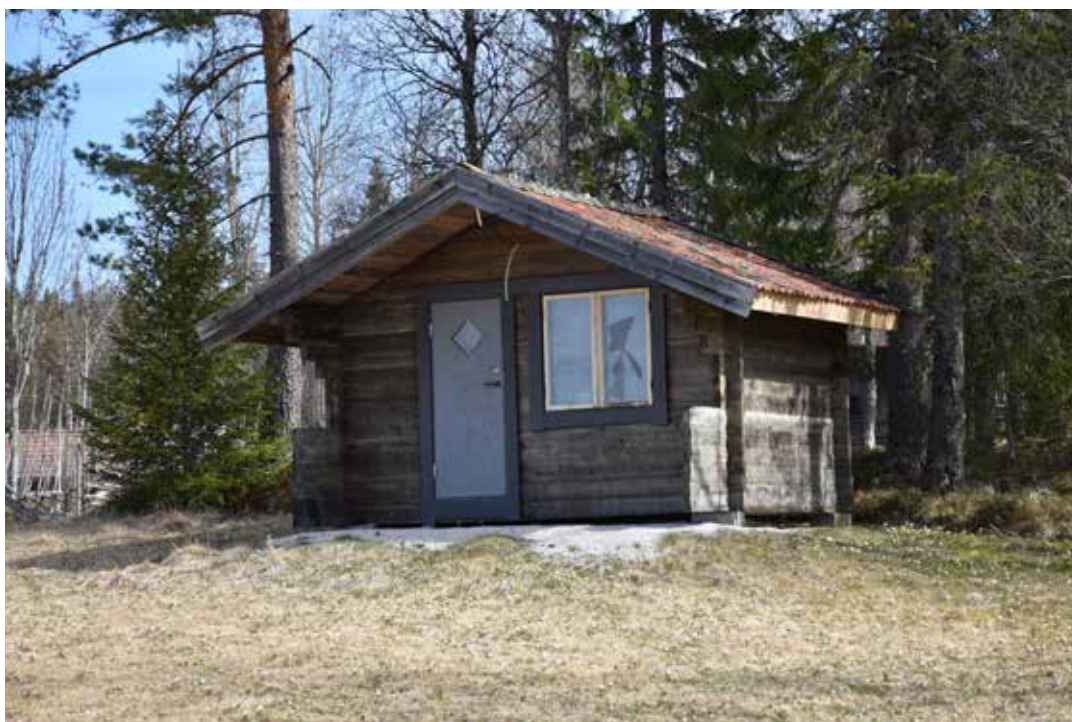
En nyligen tillkommen friggebod av modernt snitt, ett av få senare tillägg på fäbodområdet.
