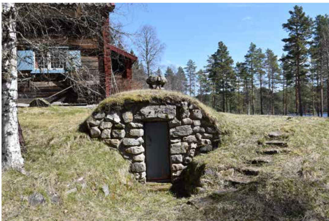
En av fåbodmiljöns enda stensatta byggnader, en jordkällare som troligtvis tillkommit under 1900-talet. Tällberg 23:10.
