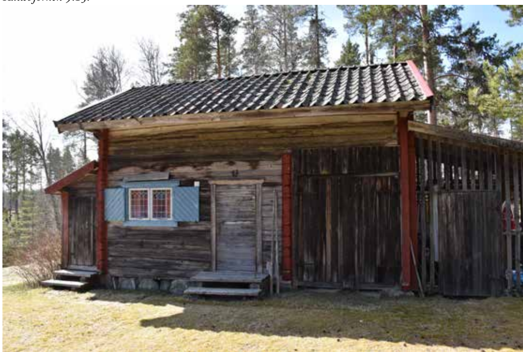
En av fåbodbyggnaderna vid Gäddtjärn. Byggnaden har ursprungligen varit ett portlider som sedan byggt om till stuga. Blyspröjsade fönster och rödmålade knutskallar har tillkommit under 1900-talet. Tällberg 23:10.
