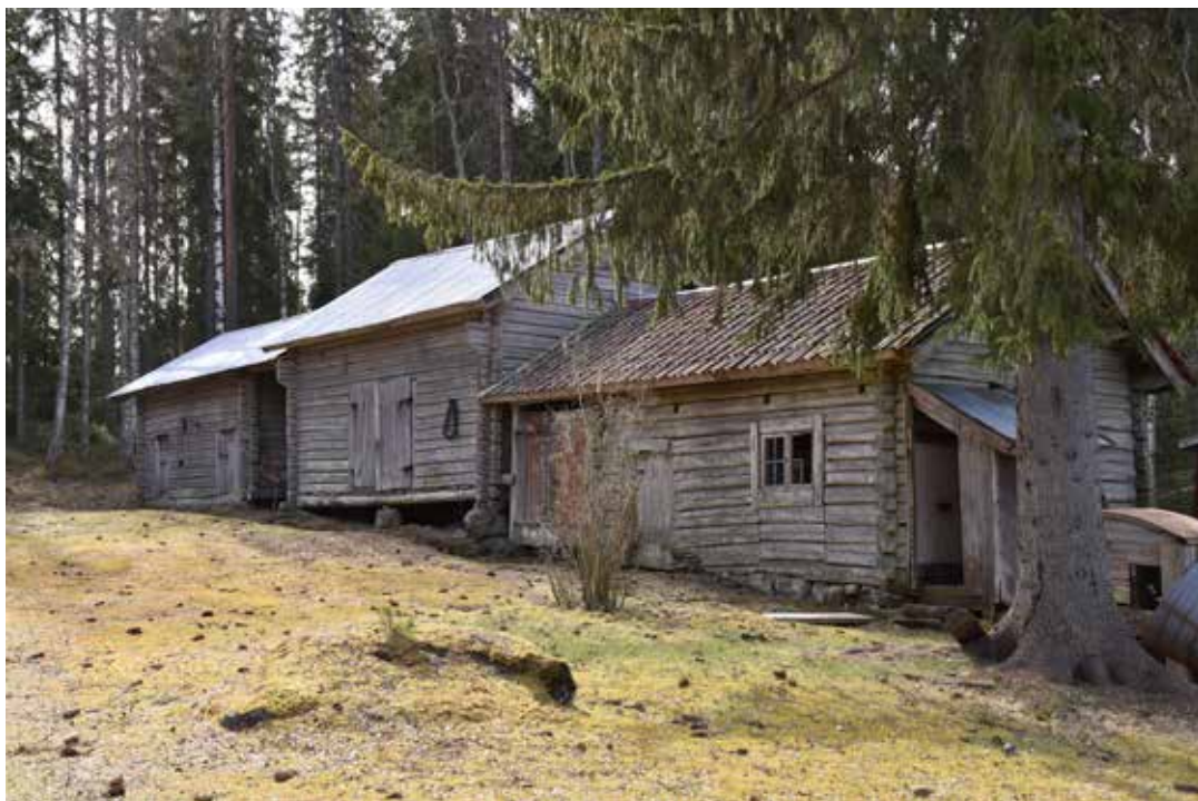
Naturligt grånade timmerbyggnader där även snickerier lämnats ofärgade ger ett ålderdomligt intryck och besitter höga bevarandevärden. Östanhol 3:14.
