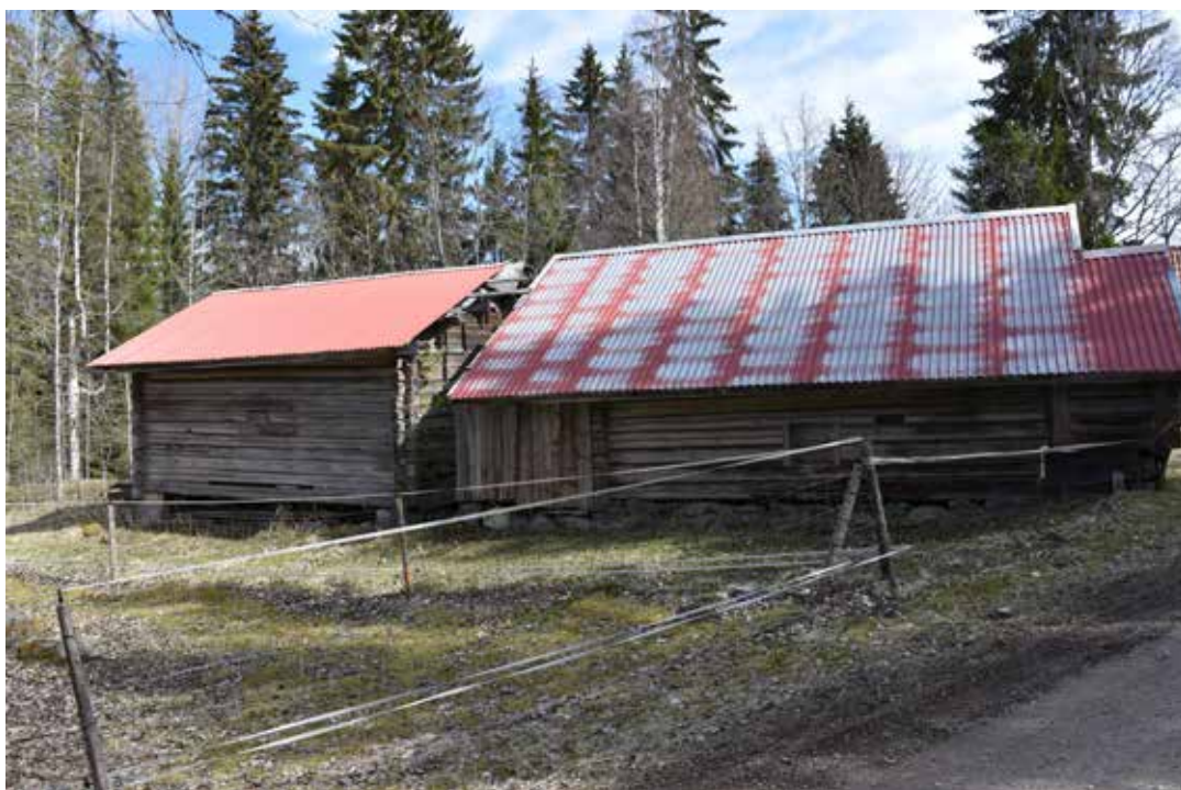
Även om tvåkupigt lertegel är vanligt förekommande finns även ett stort antal byggnader på fäbodsområdet som försetts med korrugerade plåttak. Lahnäs 39:9.
