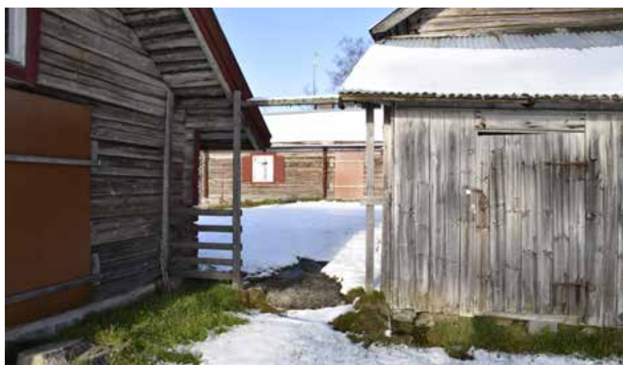
En av de äldre fäbodgårdarna är kringbyggd med fyrkantig form, vilket är utmärkande. Hagen 12:37.
