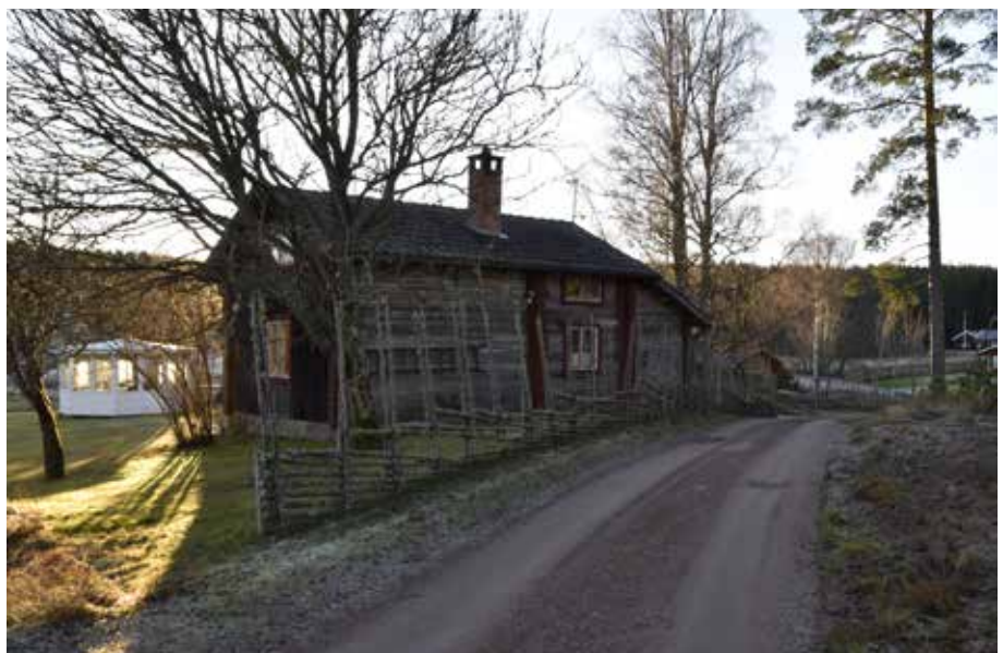
Ålderdomlig grånad enkelstuga på fastigheten Yttermo 33:24. Byggnaden är det bäst bevarade äldre bostadshuset i Kräkbodarna och kan ha uppförts som fäbodstuga.
