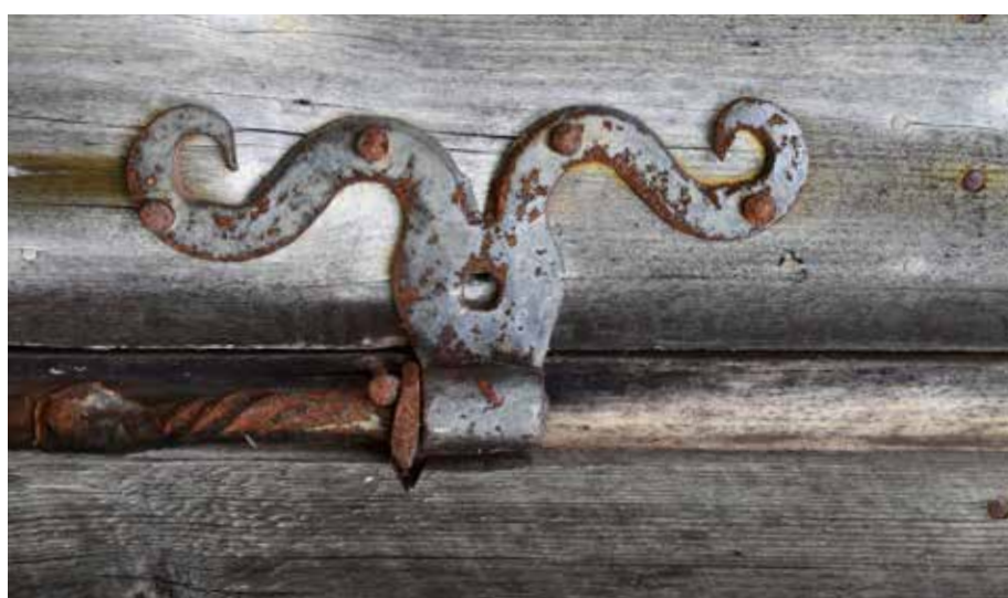
Detalj på uthusdörr. Omsorgsfullt smitt bockhornsgångjärn av typisk 1600-1700-talsmodell. Västra Rönnsås 18:10
