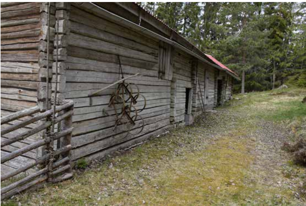
Baksidan av en naturligt grånad logeliderbyggnad. Östra Rönnsås 21:3.
