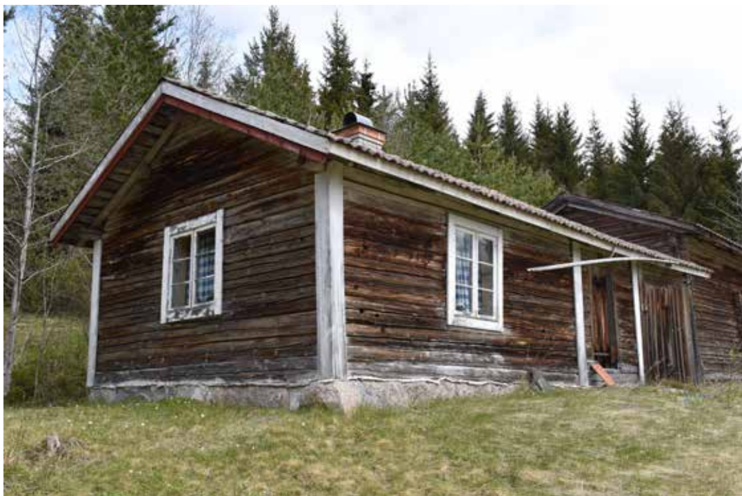
Välbevarad enkelstuga som troligen varit rödfärgad. Östra Rönnäs 27:6.
