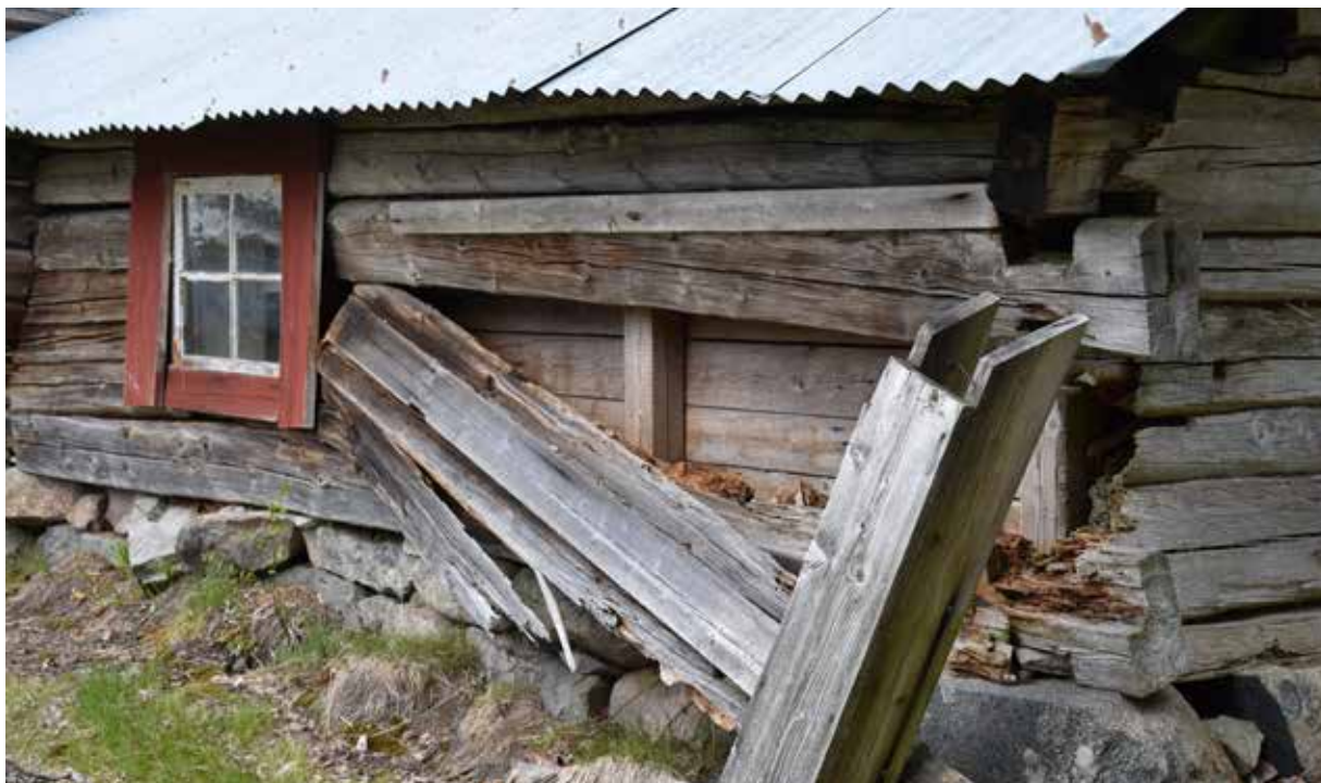
Äldre timmerbyggnad där flera stockvarv fallit ur långsidan. I förgrunden står en knutlåda som en gång omfattat husets knutskallar. Östra Rönns 27:6
