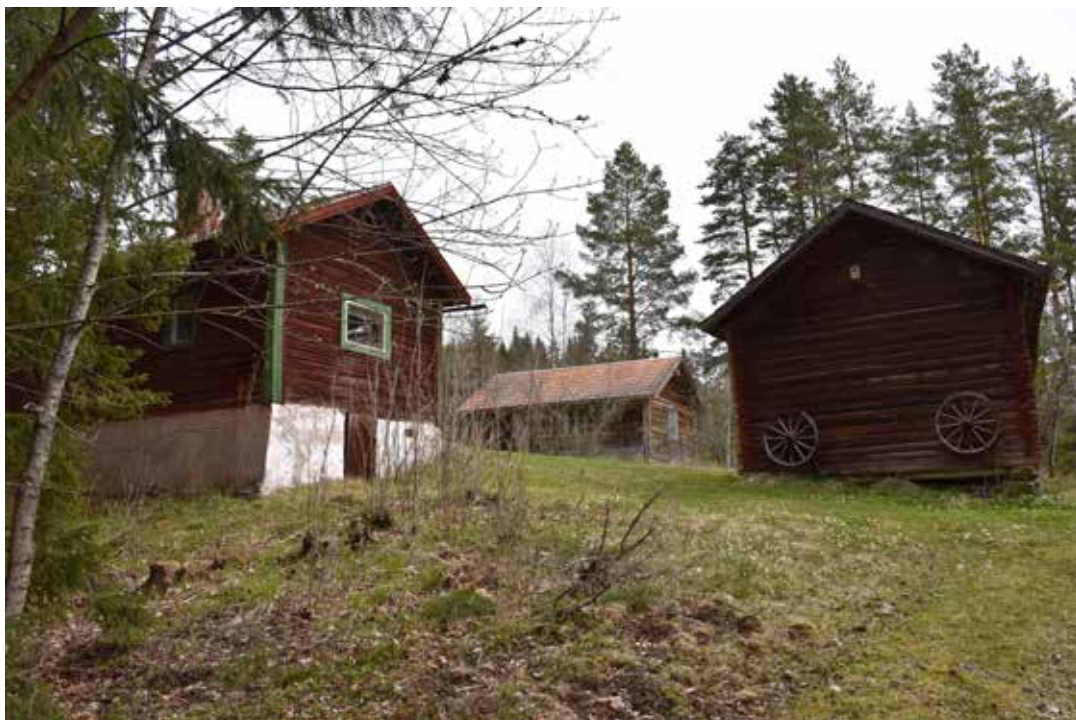
Kringbyggd gård med stuga som moderniserats på 1960-1970-talet. Hälla 2:4.
