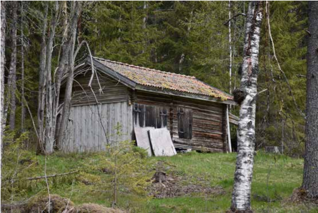
Mindre lider som sedermera byggts in med brädpanel. Ullvi 14:15.
