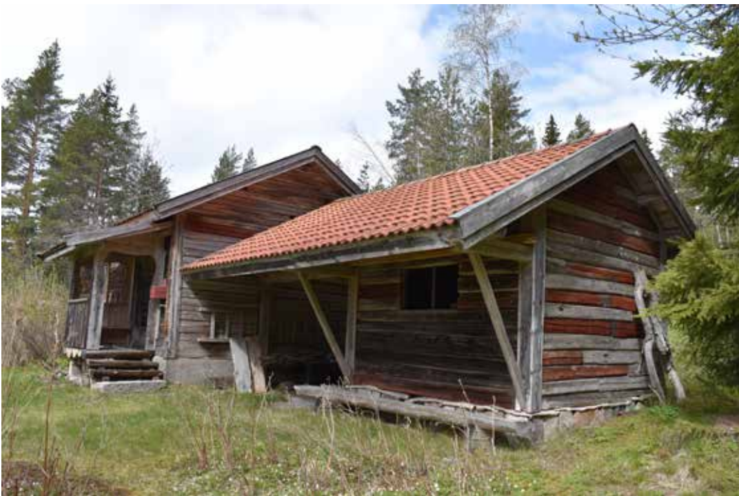
Enkelstuga med senare tillbyggnad av återanvänt timmer. Farstuvisten på den äldre delen är troligen också senare tillkommen. Ullvi 14:15.
