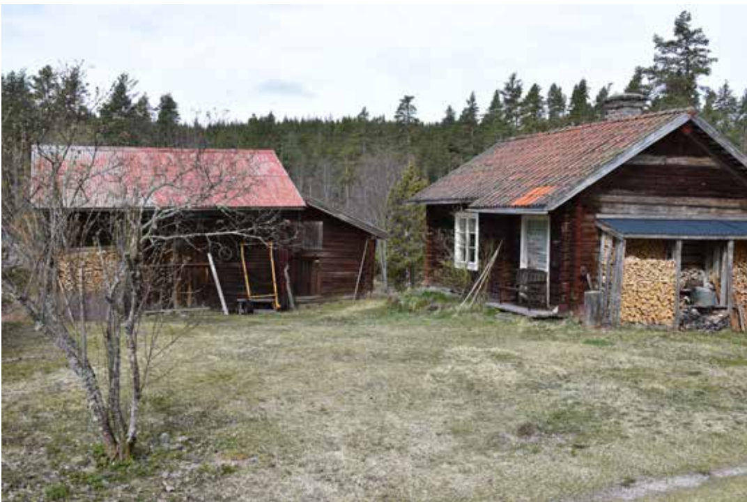
Stugorna är i regel små på fäbodarna. Till höger ses en rödfärgad enkelstuga med vitmålad fönsterfoder. Laknäs 4:22.
