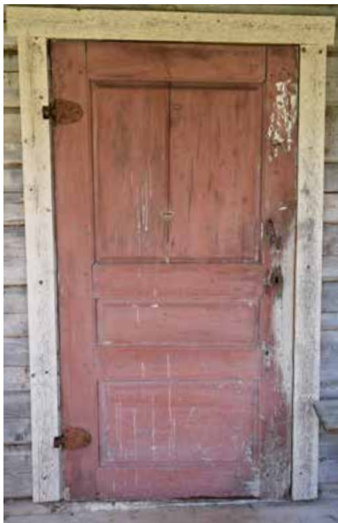
Äldre spegeldörr med smidda beslag. Troligen tidigt 1800- eller sent 1700-tal.
