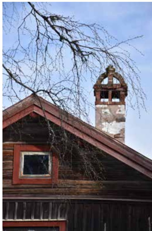
Så kallad kronskorsten. Ovanliga på fäbodrar men desto vanligare på sommarnöjen.
