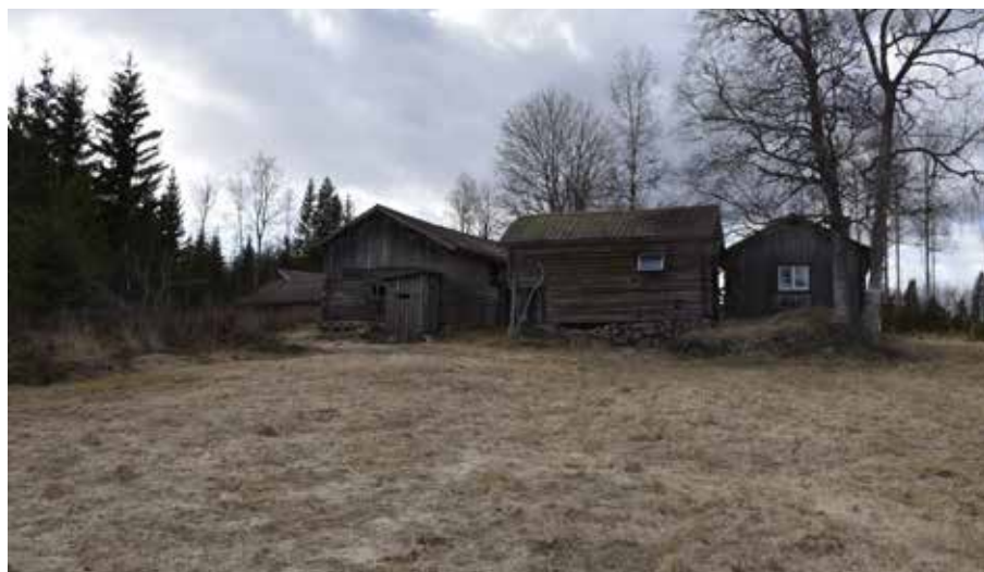
Fäbodgårdarna är belägna i markerade höjdlägen som erbjuder god vattenavrinning. Plintberg 15:8.
