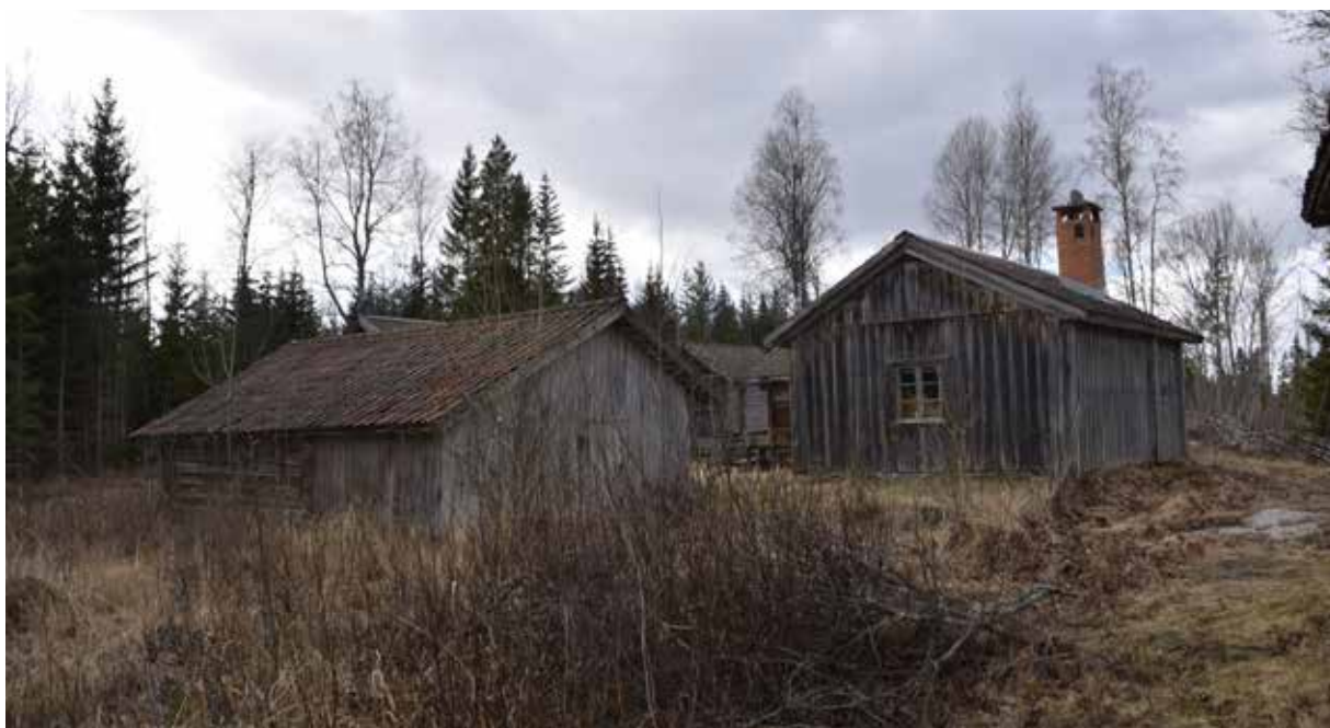
Den fyrkantsbyggda gårdsformen som fortfarande förekommer på två gårdar i Sör Bertilsbo är ovanlig idag. Plintsberg 16:16.
